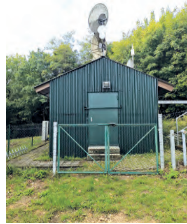
Die Queste-Hütte mit der Gemeinschaftsantennen-Anlage (Kopfstation). Foto: Gemeinschaftsantenne Schmalkalden GmbH
